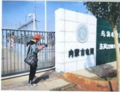
东风变电站大门口噪声检测
