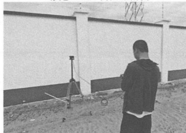
220kV 升压站西侧
