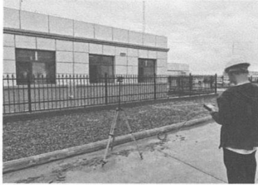
220kV 升压站北侧
