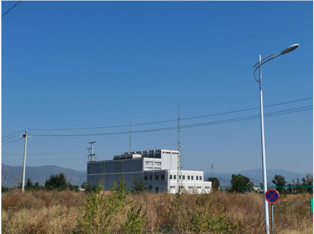
附图三 本项目已建变电站照片
