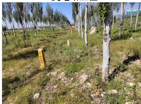
电缆线路现状
