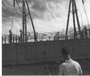
盐海 220kV 变北
