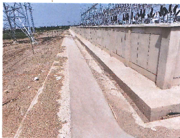
禄安变南侧围墙
