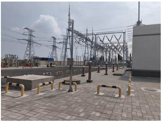
蓄水池和消防水泵房
