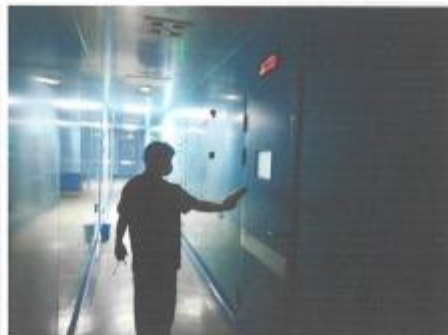
DSA机房污物通道防护门
