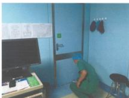
DSA机房控制室防护门
